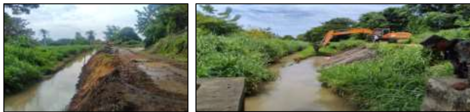
Limpeza Canal Los Veteranos / Limpeza Dique # 1 Canal Caño Frio (Dajabón)
